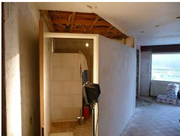
Aanleg appartement begane grond Stiltij – centrum Moorveld
