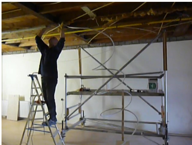
Aanleg bekabeling aan plafond zendo Stiltij – centrum Moorveld
