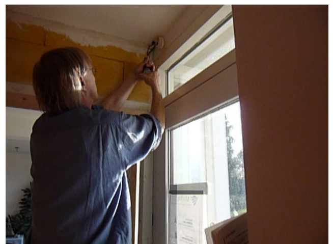
Lichtpunt maken in de nieuwe entree Stiltij - centrum Moorveld
